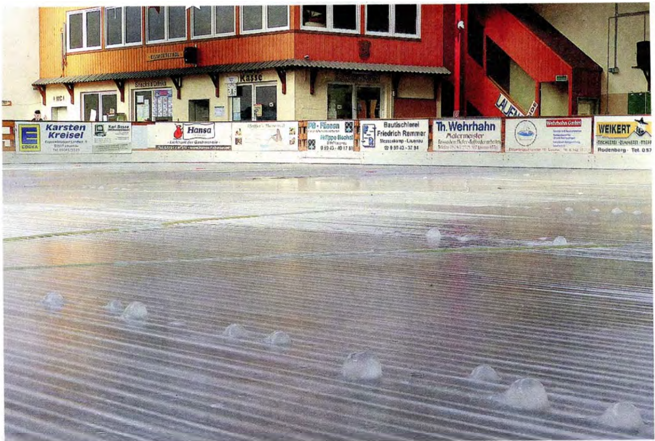
Der große Temperaturunterschied zwischen dem sonnigen Herbstwetter und der inzwischen kühlen Eishalle lässt „Stalagmiten“ wachsen. nah
