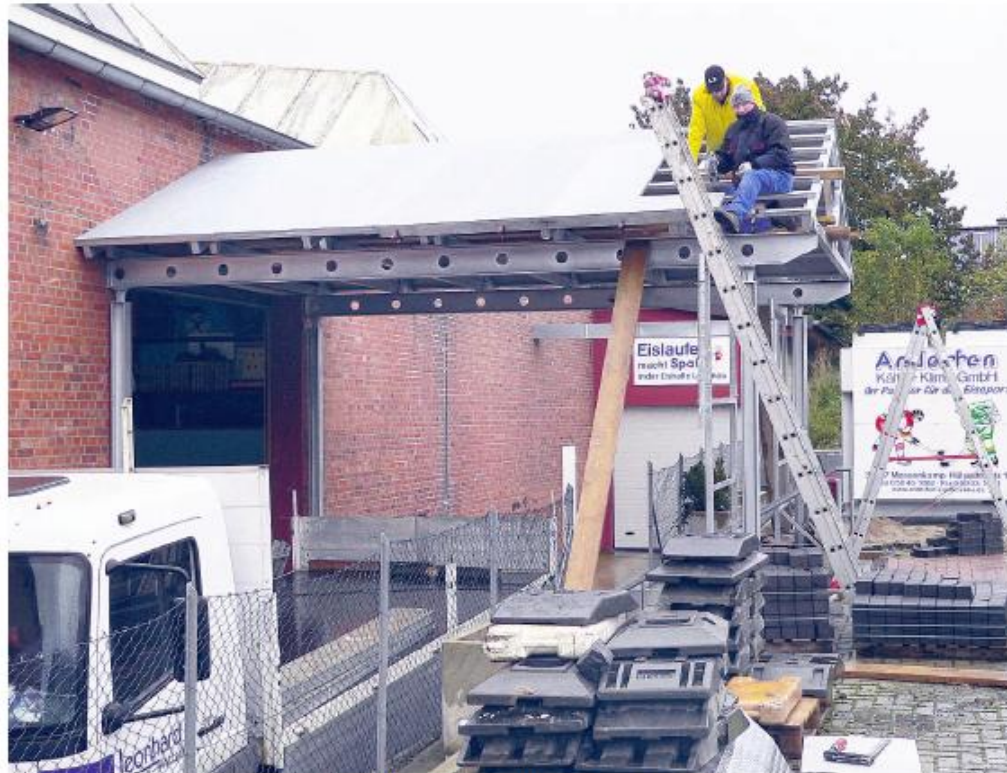
Über dem Eingang zur Lauenauer Eishalle wölbt sich künftig eine Stahlkonstruktion.
