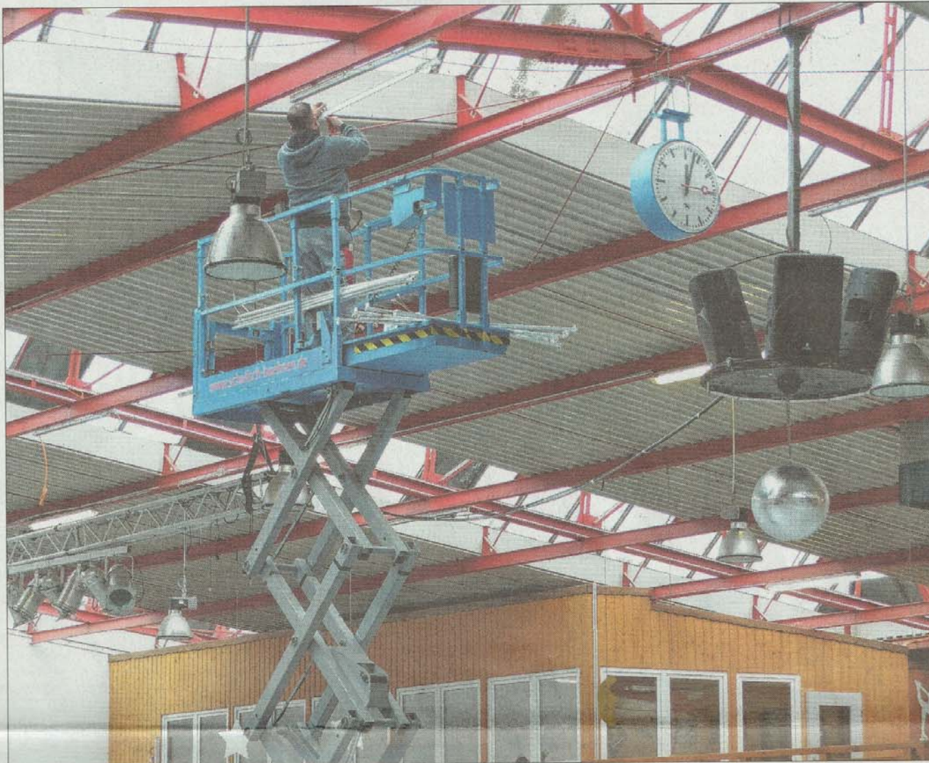
Scherenbühne auf dem Eis: Elektriker verlegen Leitungen für die Brandschutzvorrichtungen.
